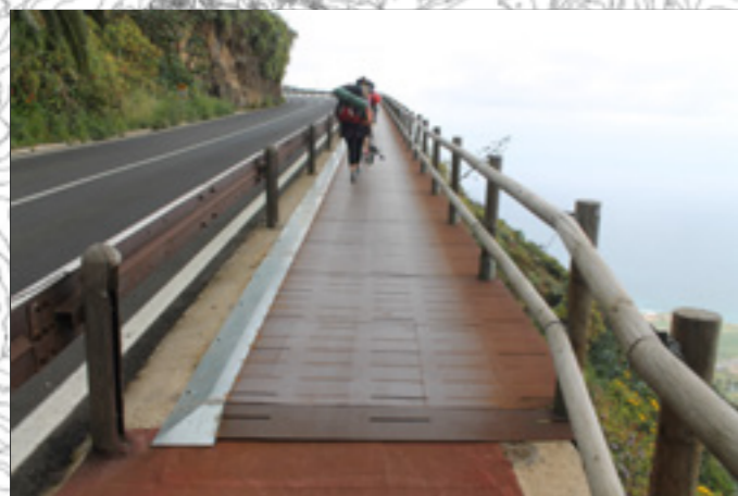
Tramo de carretera con recorrido peatonal. Fotografía: Icod el Alto, Tenerife.
