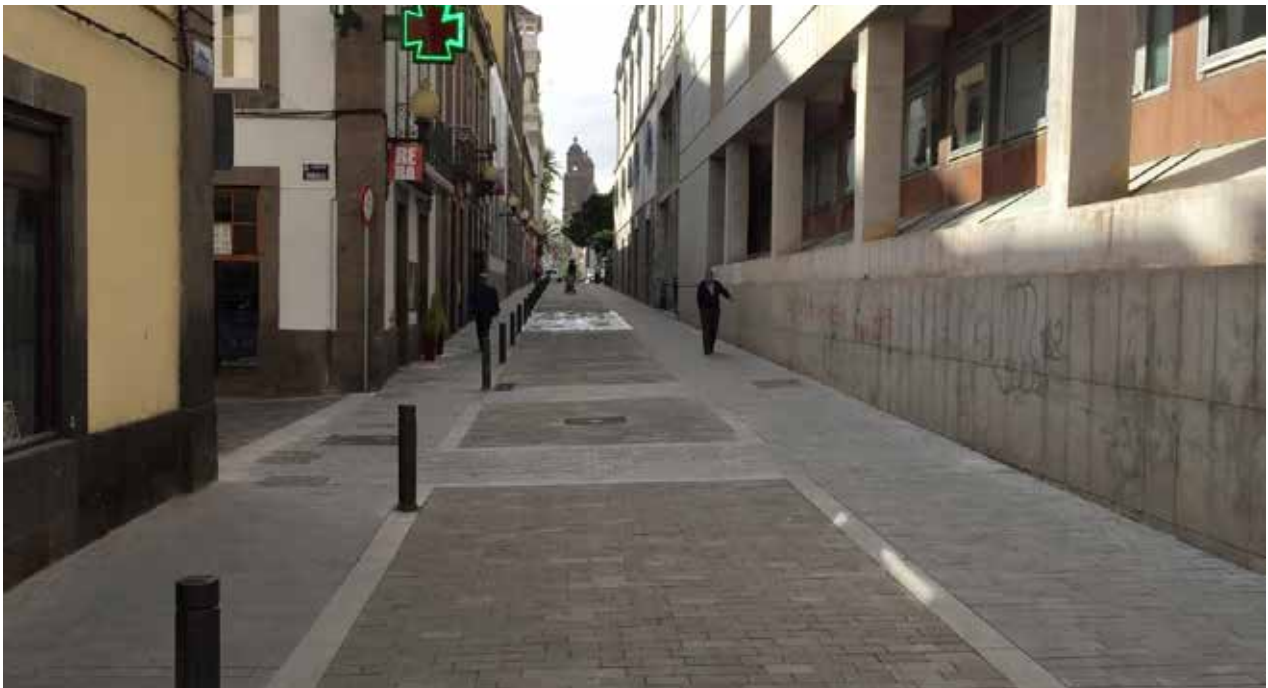
Uso de pavimentos al mismo nivel y separación de flujos mediante bolardos. Calle General Bravo en Las Palmas de Gran Canaria.
