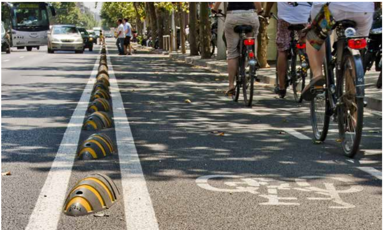
Ejemplo de carril bici separado del tráfico motorizado de vehículos.
