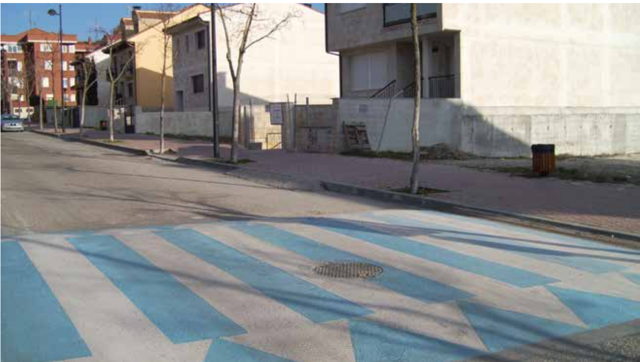
Ejemplo de badén en la calzada.
