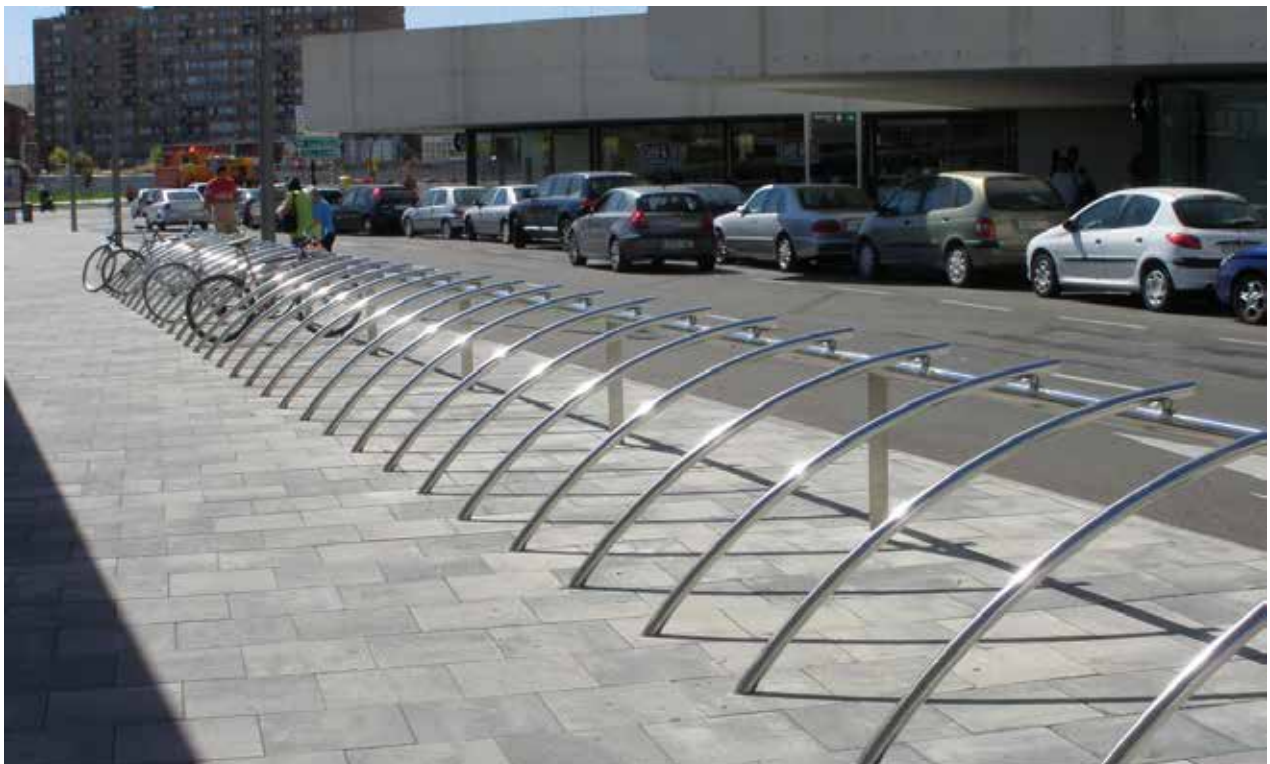
Aparcamiento de bicicletas con estructura metálica.
