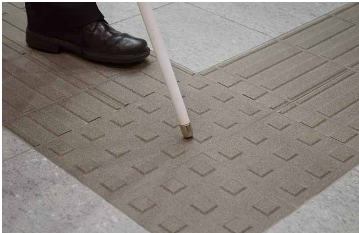
Pavimento especial para invidentes que les ayuda a desplazarse en el espacio urbano.
