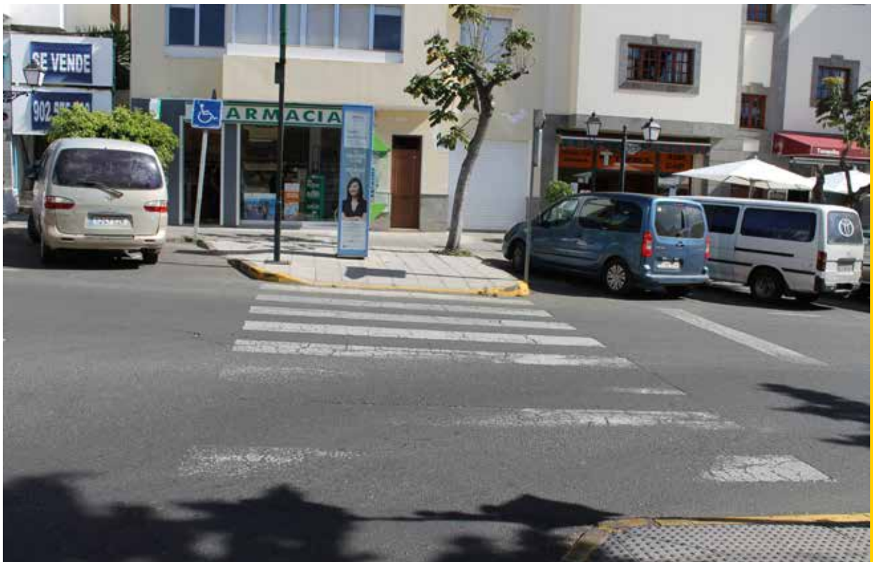
Paso de peatones degradado en la calle Juan Carlos I.
